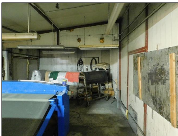
Widok wewnątrz budynku
