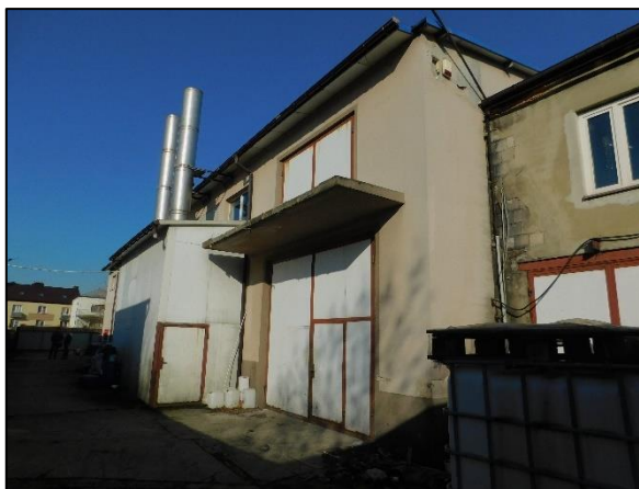
Widok wewnątrz budynku
